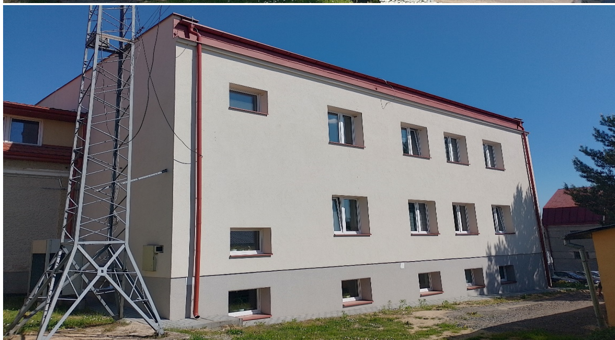
Fot. nr 9-10 Termomodernizacja budynku Urzędu Gminy w Gorzkowie
