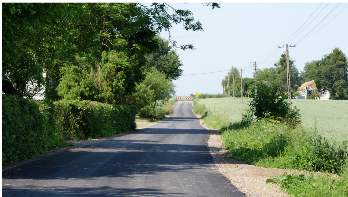
Fot. nr 5 Przebudowa drogi gminnej w msc. Antoniówka
