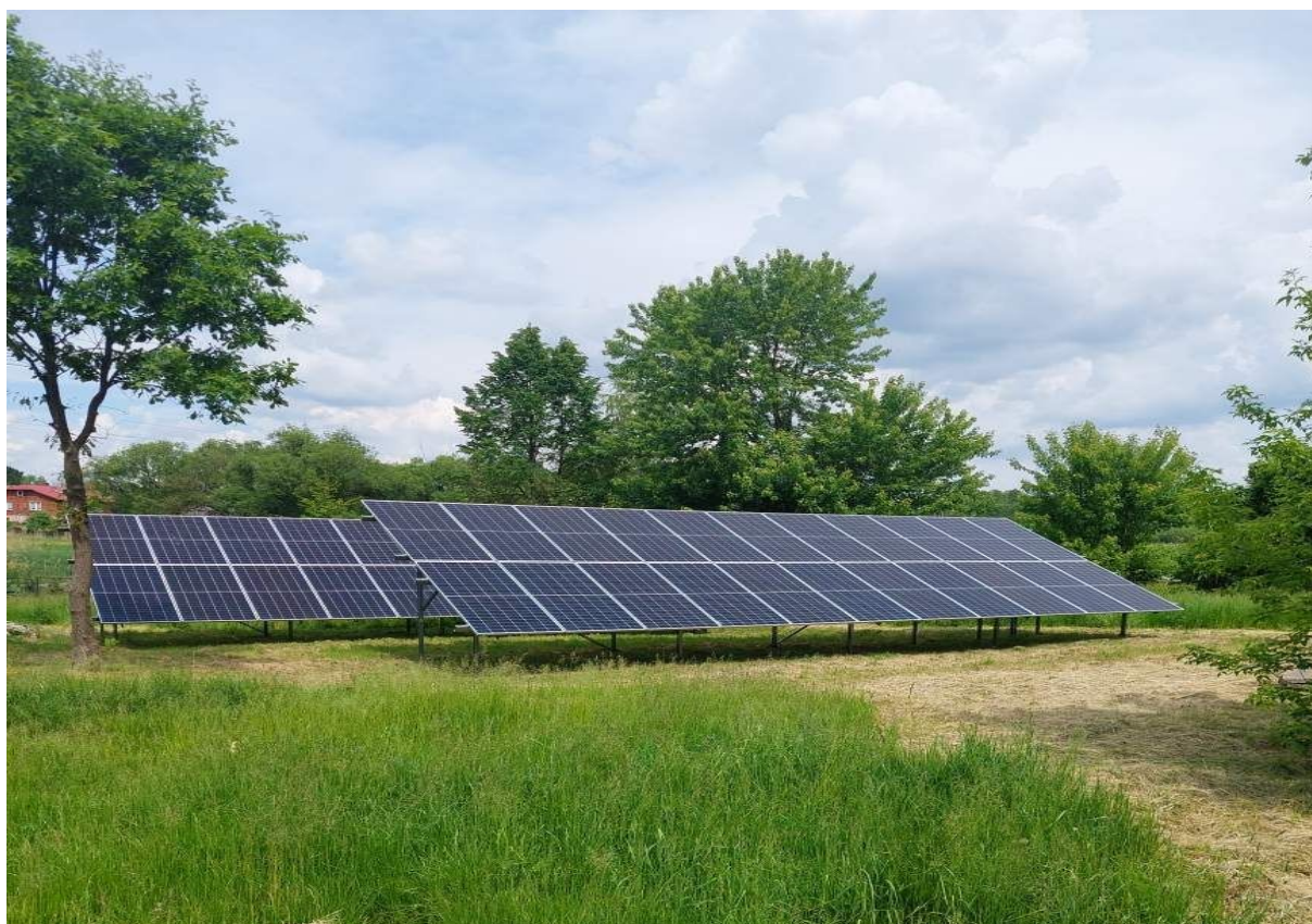
Fot. nr 6 Modernizacja oczyszczalni ścieków poprzez budowę instalacji fotowoltaicznej
