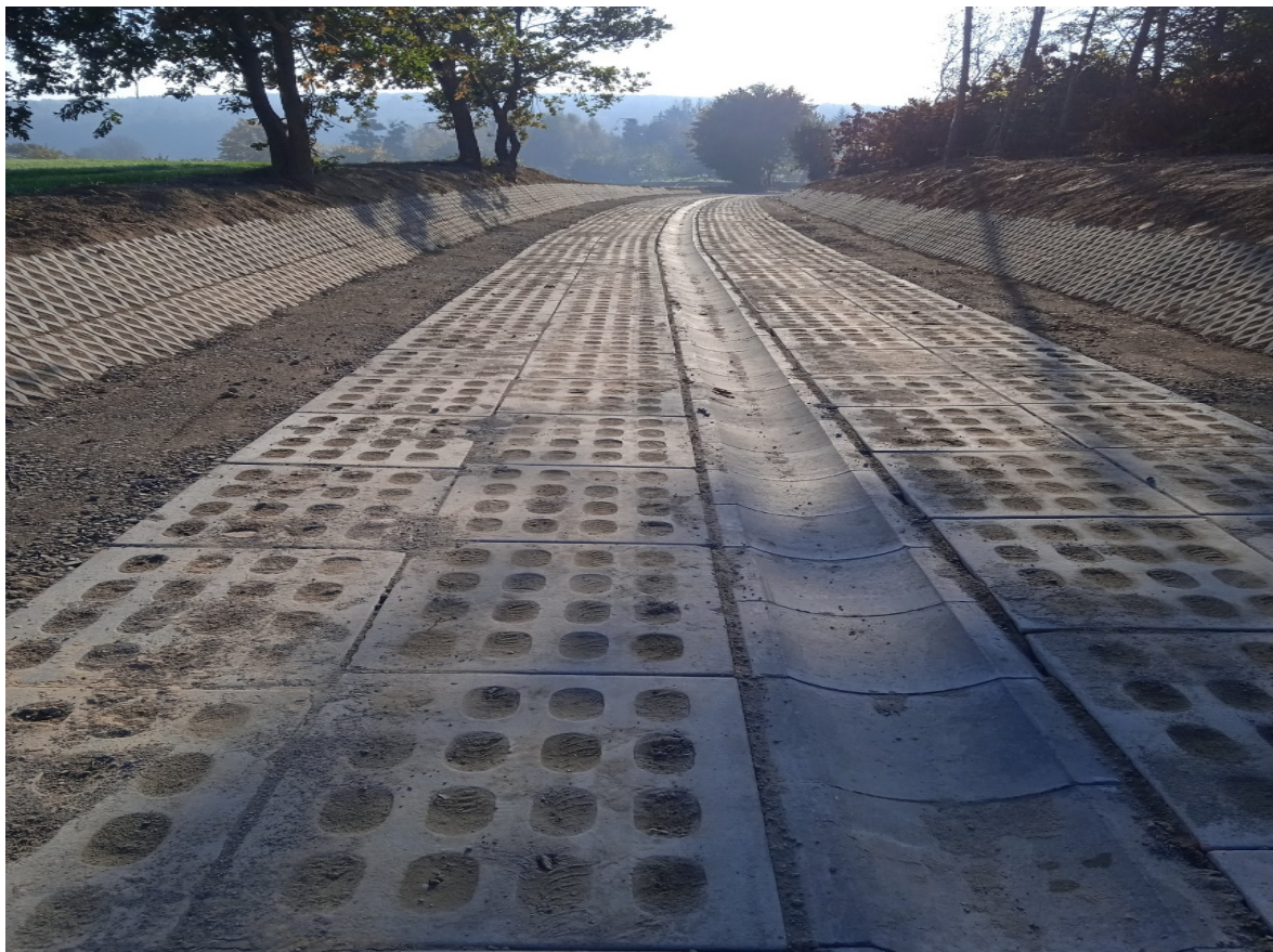
Fot. nr 7 Budowa drogi gminnej w msc. Wielkopole
